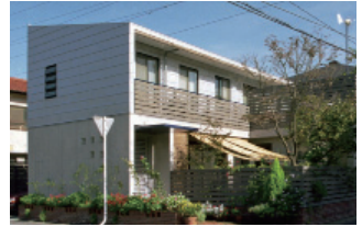
街角側の外観
