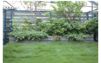
屋上の芝生と植栽(DIY施工)
