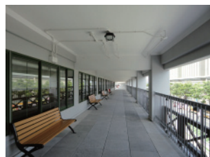
改修された2階屋外通路
