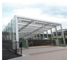
八幡駅南北連絡地下通路
