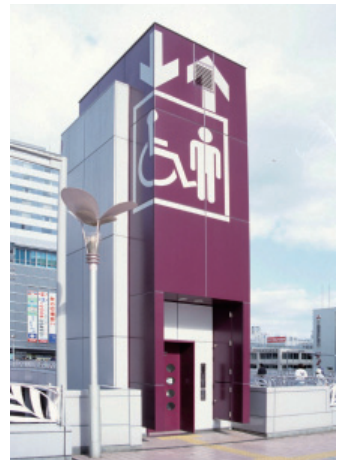
身障者エレベーター
