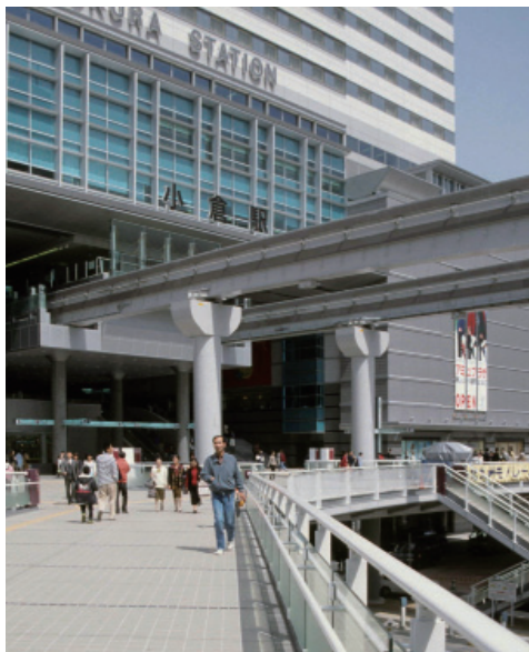
南西放射デッキから駅側を望む
