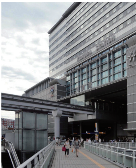
南東放射デッキから駅側を望む
