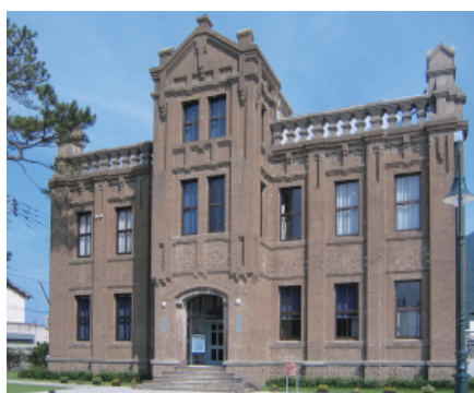
修復された正面外観
