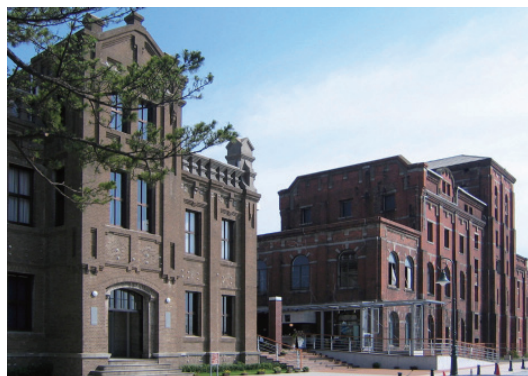
門司麦酒煉瓦館と醸造棟の外観
