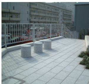
復元された万代橋の橋面
