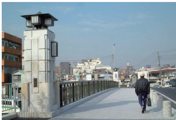
復元された万代橋の橋面
