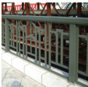
復元された万代橋の橋面
