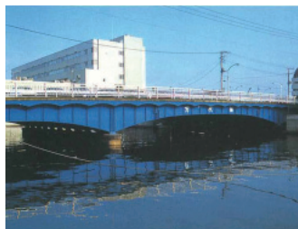
震災復興橋梁・旧「萬代橋」の解体前写真
