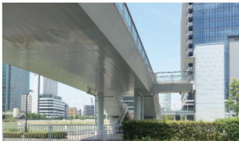
高島中央歩道橋のシンプルな箱桁を採用で支間長 28m で桁高 0.7m を実現した
