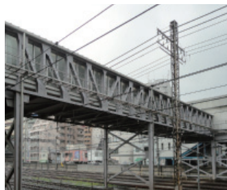
改修後の鶴見駅人道橋の外観
