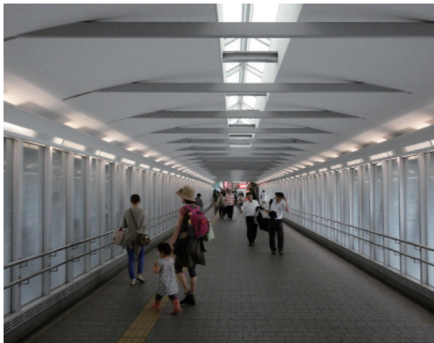
天井にトップライトを設けることで明るくなった通路、側面は全面アルミハニカム組込みペアガラス
