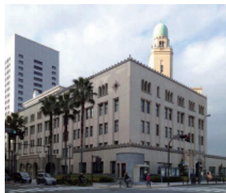
改修後の横浜税関本関庁舎
