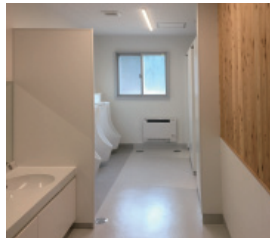
北御牧小のトイレ改修後
