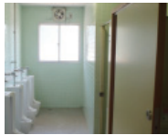
北御牧小のトイレ改修前
