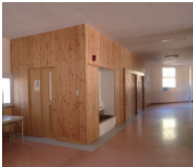
北御牧小のトイレ改修後
