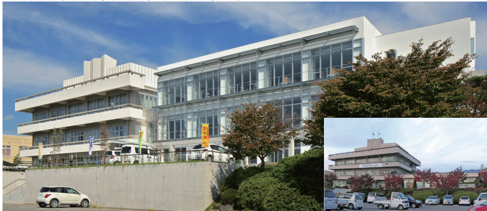
改修後 庁舎南側全景 本館（既存）東側に増築*
