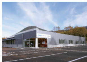
屋内体育施設・特設プール入口（外観）
