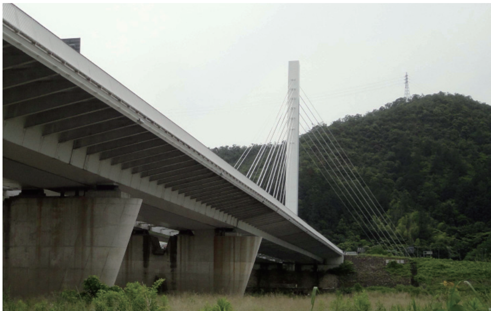
右岸高水敷より鵜飼大橋の橋桁と主塔を見上げる（竣工後 17 年経過時点）
