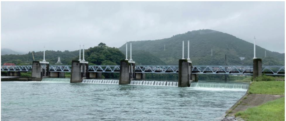
完成から20年近く経過した可動堰と管理橋、年数を経てコンクリート製堰柱は苔や黴で黒くなり、現地の風景に溶け込んでいるようにも見える
