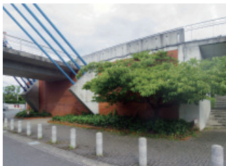
橋のアンカレージと一体化された公園部レンガ擁壁
