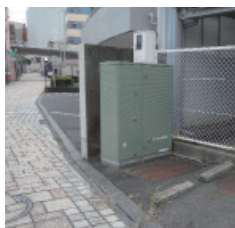
電線地中化のトランスは民地側に設置
