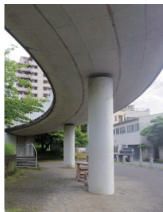
公園橋の桁下空間
