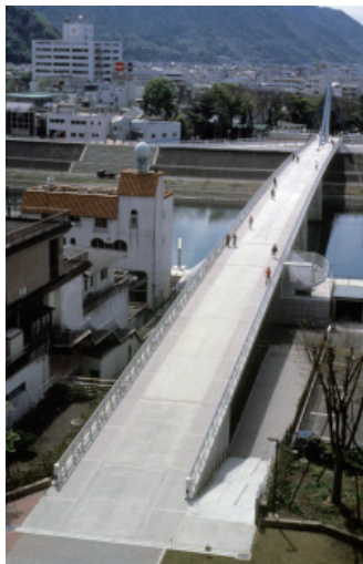
あゆみ橋の鳥瞰写真（右岸側）*
