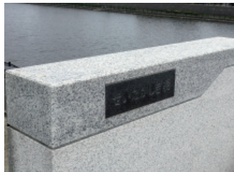
石の親柱に埋め込まれた橋名板
