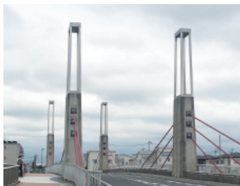
車道側から橋の主塔と上部照明の構成をみる
