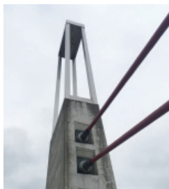
主塔上部の照明フレーム
