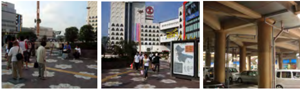
改修前のデッキ上部の状況、施設の老朽化が著しい/下部の状況、暗く多くの配管類が露出
