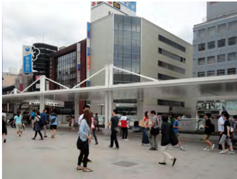
駅出入口に新設した連続上屋
