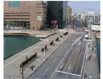
歩道内の公園区域と道路区域の境界部にプランター設置
