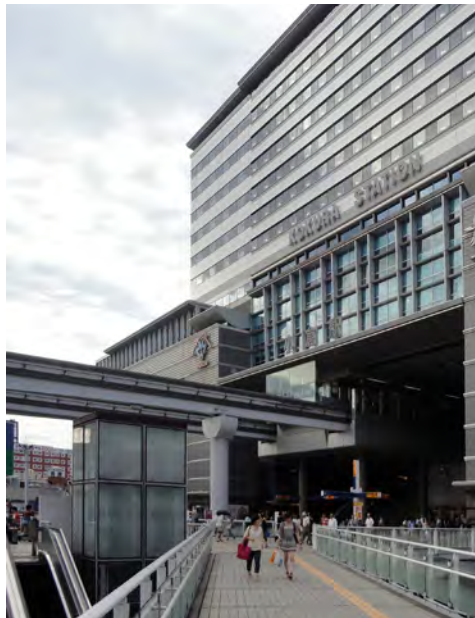
南東放射デッキから駅側を望む
