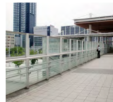
防風のためのガラス高欄
