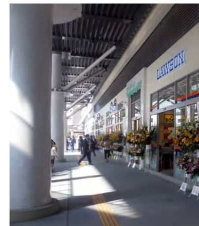
地上部デッキ下部から天井有孔折板を望む
