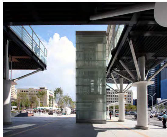
地上部デッキ下部から中央広場を望む、中央のガラスの箱がコネクターキューブ
