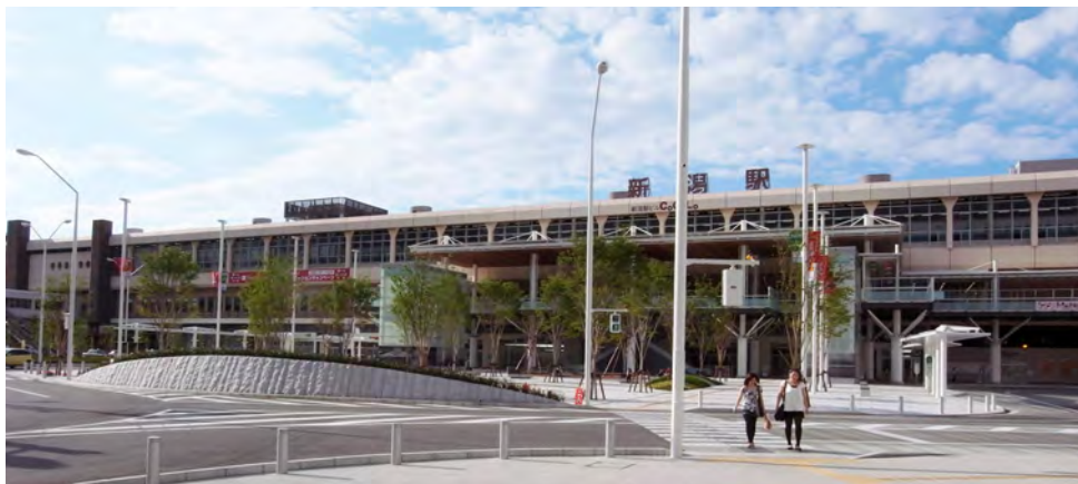
弁天線側よりみた南口広場
