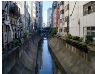
改修前の渋谷川
