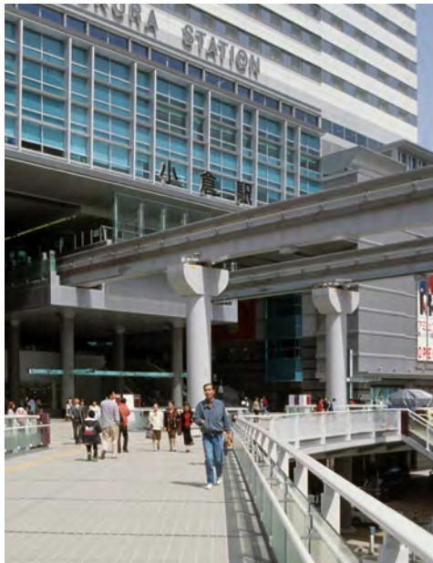
南西放射デッキから駅側を望む
