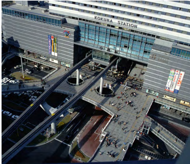
小倉駅南口ペDESTリアンデッキ全体写真
