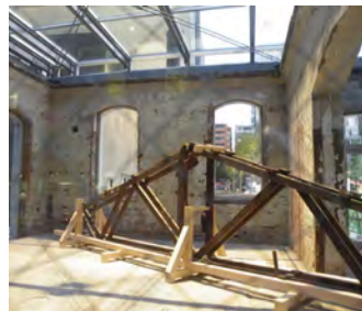
旧48番館の内部とガラス屋根
