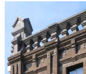
麦酒煉瓦館の屋上パラペット部の復元・補強
