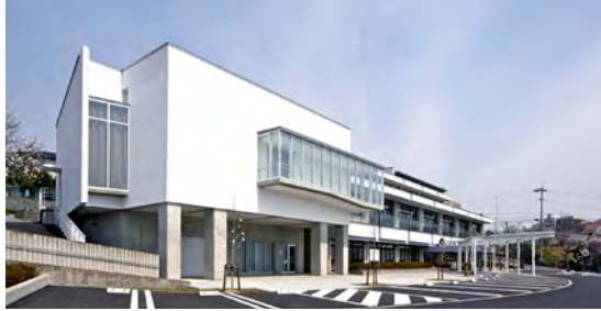
中央公民館の増築部分（講義棟一正面）と改修された本館（改修）*
