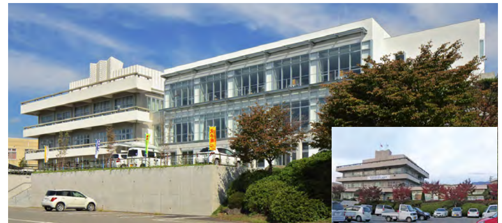
改修後 庁舎南側全景 本館(既存)東側に増築*
