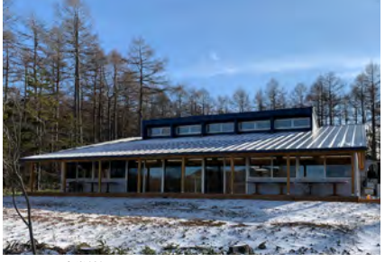
アスリート食堂外観
