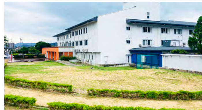
南庭：東側築山頂部からウェルネスセンター中央と前面の草地広場を望む
