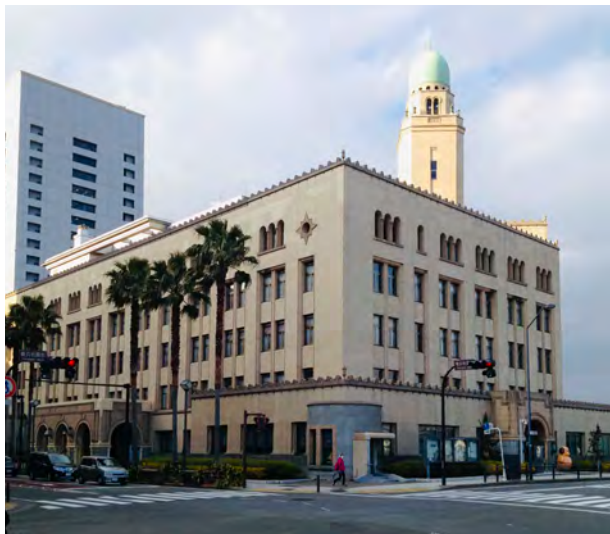
改修後の横浜税関本関庁舎
