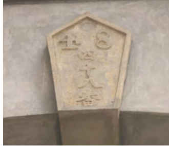
旧48番館創建当時とされる建物入口キーストーン
