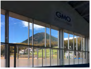
屋内体育施設内から 400mトラック側を望む
