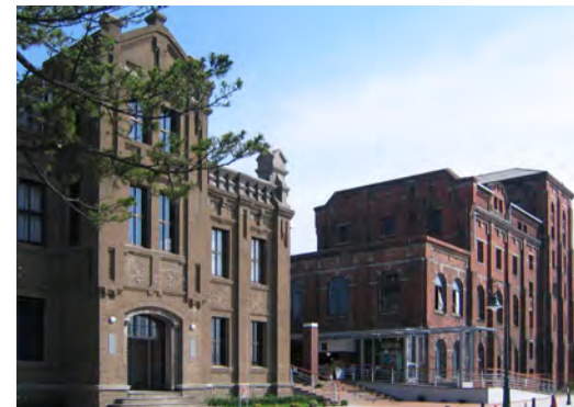
門司麦酒煉瓦館と醸造棟の外観
