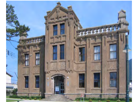
修復された正面外観
