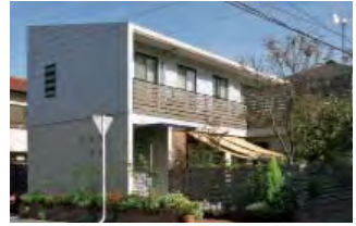
街角側の外観
