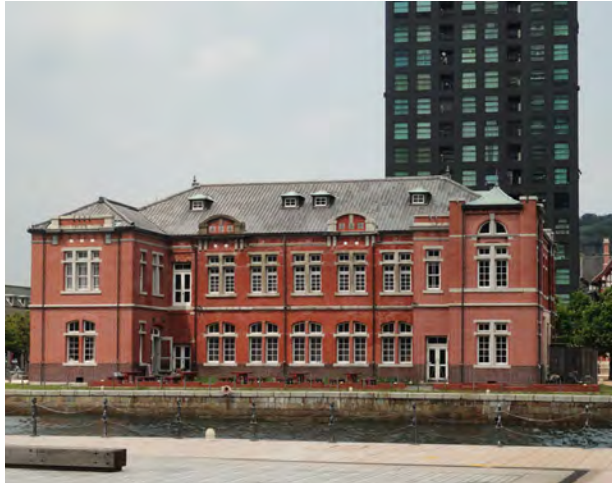
改修後の外観(第一船溜まり側、両翼を復元も水際のかつての平屋部は外構でイメージ復元)
