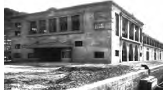
改修前の大連航路上屋
