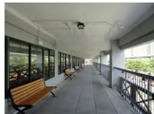
改修された2階屋外通路
