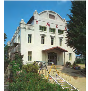
解体直前の調査対象となった北九州YMC A学校法人北九州学園YMC A信愛幼稚園(旧YMC A門司プラザ、1916(大正5)年築、レンガ造2階建て、設計者はデラランドと言われていたが、確認は得られなかった)
