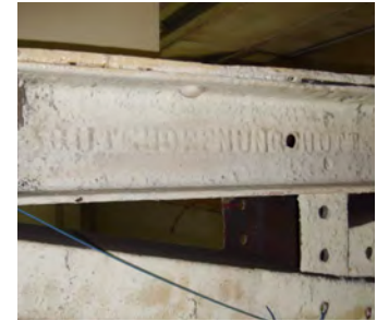
旧鍛冶工場の鋼材にドイツからの輸入材であることを示す Gute Hoffnungs Hütte（G.H.H.社）の刻印
