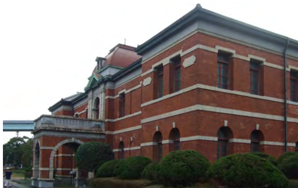
旧本事務所（1899年築・赤煉瓦積石造2階建 延床面積1,023㎡・調査時点での写真）
