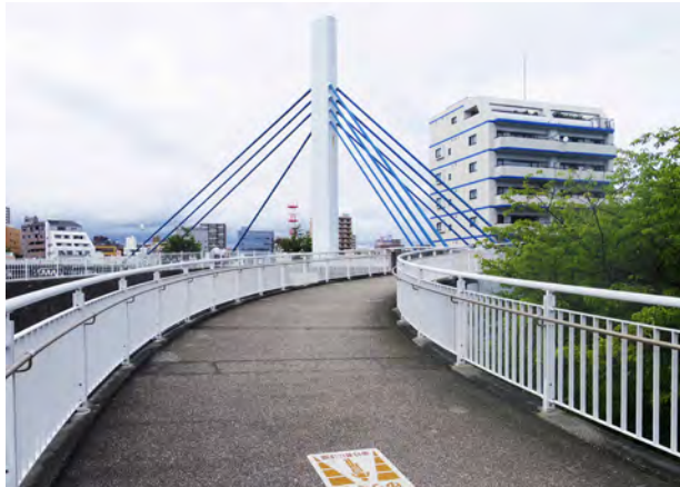
香貫公園の通路上から見るあゆみ橋主塔
