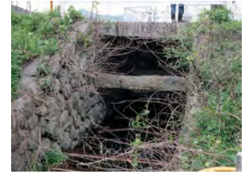
江戸期の取水口石積(中野が現場立会て変更協議の結果、保存が実現した経緯がある)
