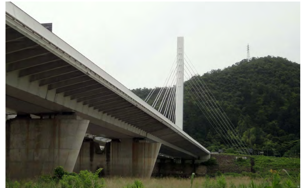
右岸高水敷より鵜飼大橋の橋桁と主塔を見上げる(竣工後17年経過時点)
