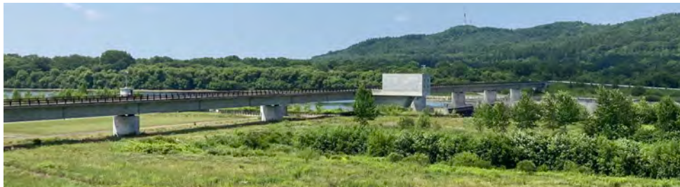
十勝川千代田新水路管理棟(国土交通省北海道開発局帯広開発建設部現地事務所) 屋上から管理橋とゲート機械室棟および新下水路を望む
