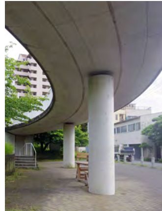
公園橋の橋下空間
