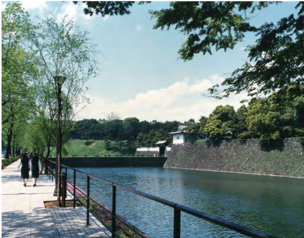
改修整備後の晴海通り（歩道部）の風景*
