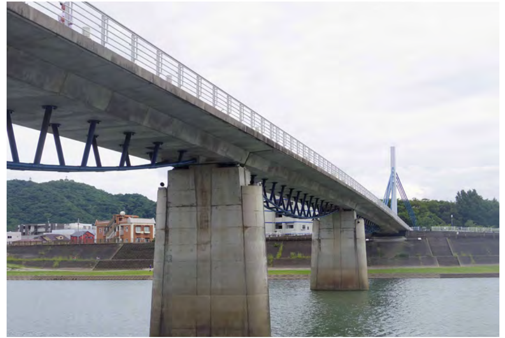
狩野川右岸高水敷よりあゆみ橋を見上げる
