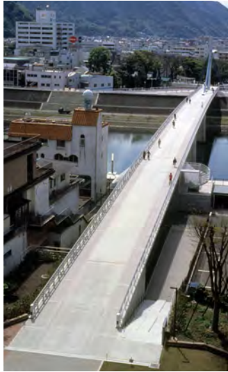
あゆみ橋の鳥瞰写真（右岸側）*
