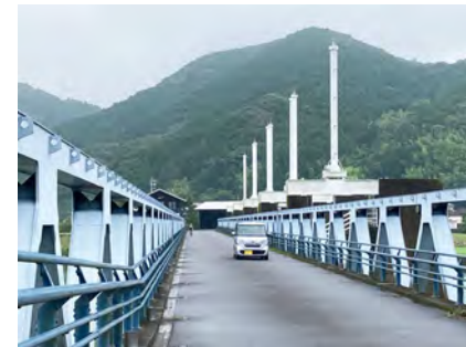
右岸側から見た管理橋と可動堰
