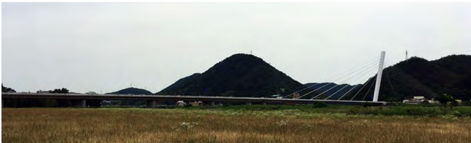
鵜飼大橋の右岸・長良川温泉駐車場からみた全景
