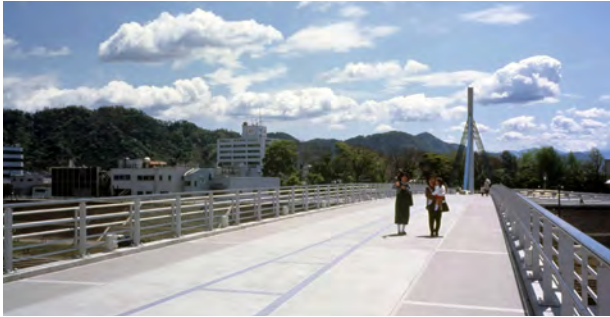
あゆみ橋の橋面*
