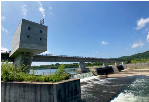
ゲート機械室(左上)と右岸管理橋、水流調節のための起伏ゲートと流れ落ちる大量の水
